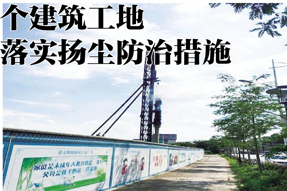
震海紫金苑工地使用冒黑烟的打桩设备。
